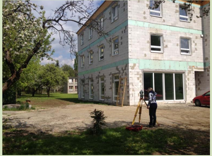
Prešov - zameranie prístavby k stavbe, r. 2016 prístroj: totálna stanica LEICA TC 1205
