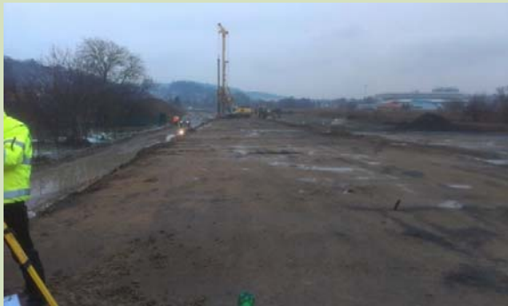
02/2013 vytyčenie pilót pre základ protihlukovej steny: I/68 Prešov, odb. Škultétyho – ZVL
