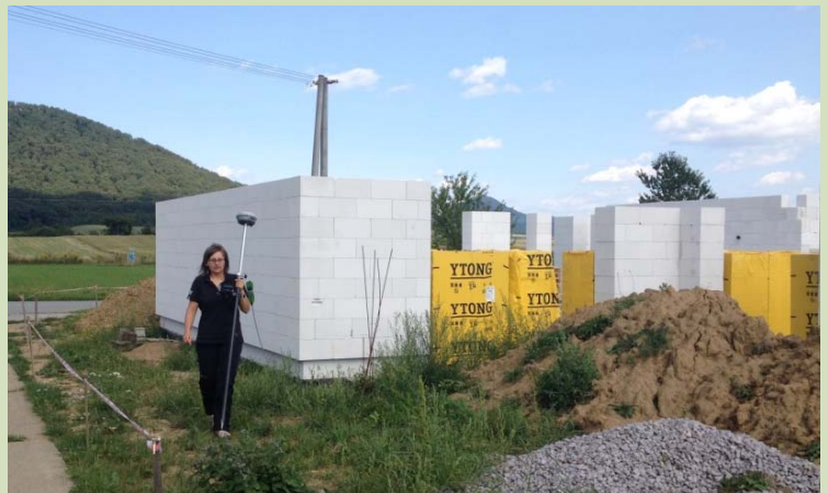
Medzany - zameranie rozostavanej stavby, r. 2017 prístroj: TRIMBLE R8 GNSS
