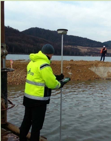
Modernizácia trate Púchov – Žilina, pre traťovú rýchlosť do 160 km/h I. etapa, vytyčovanie osi piliera z paluby pontónu
