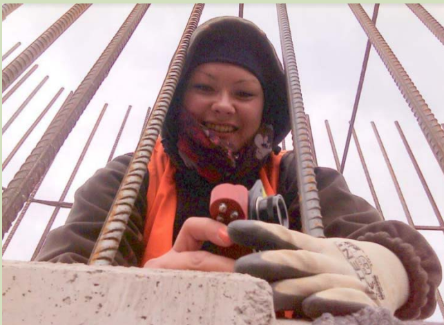
Vytyčovanie polohy piliera - križovatka ZVL / cesta I. triedy v Prešove
