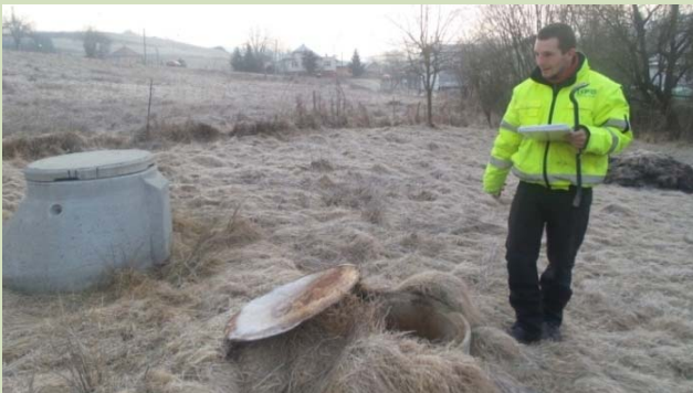
03/2015 zameranie existujúcich IS - kanál pre projekt: I/66 Brezno – obchvat
