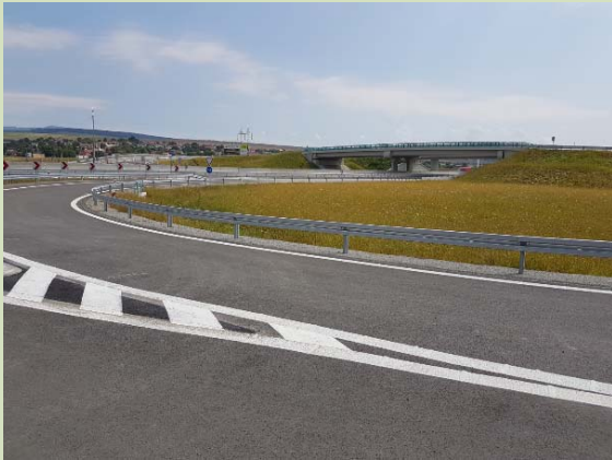
Diaľničný privádzač Nová Polhora pohľad na mimoúrovňovú križovatku
