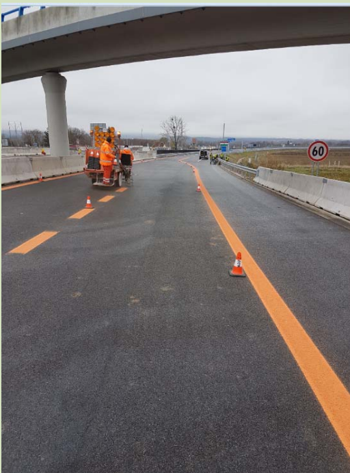
R4 Košice – Milhosť, prepojenie R4 s M30 - realizácie vodorovného dopravného značenia
