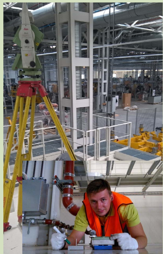
Automobilový priemysel - vytýčenie výrobnéj linky pre koncern Mercedes v NEMECKU
