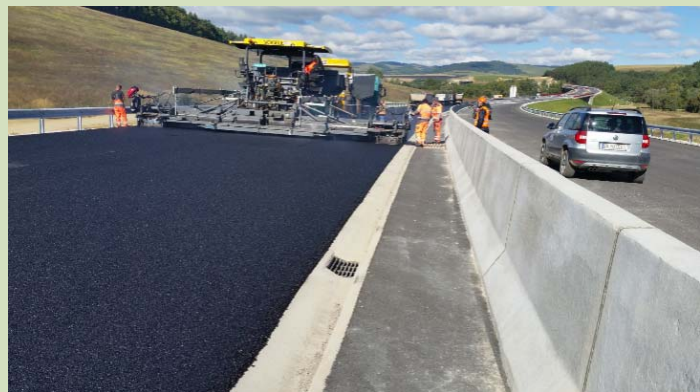
D1 Fričovce - Svinia - pokládka asfaltových zmesí
