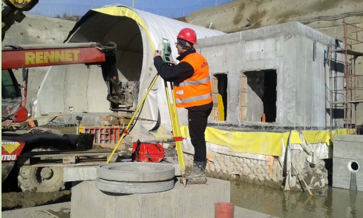
Diaľnica D1 Jánovce - Jablonov, II. úsek, Tunel Šibeník vytyčovací a zameriavacie práce pred portálom tunela
