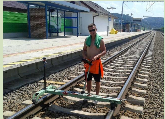
Modernizácia trate Nové Mesto nad Váhom – Púchov, pre traťovú rýchlosť do 160 km/h, III. etapa, meranie priestorovej polohy koľaje počas horúceho letného dňa
