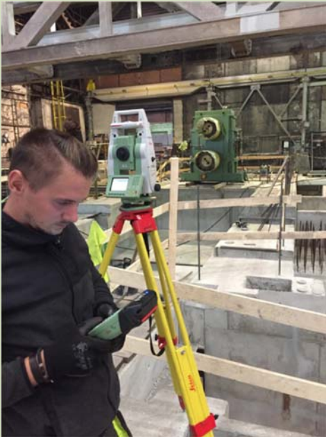
Polohové a výškové osadenie súčiastok novej Sochorovej trate v Třineckých železniarňach
