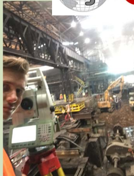
Monitorovanie stĺpov počas demolačných prác v Třineckých železniarňach
