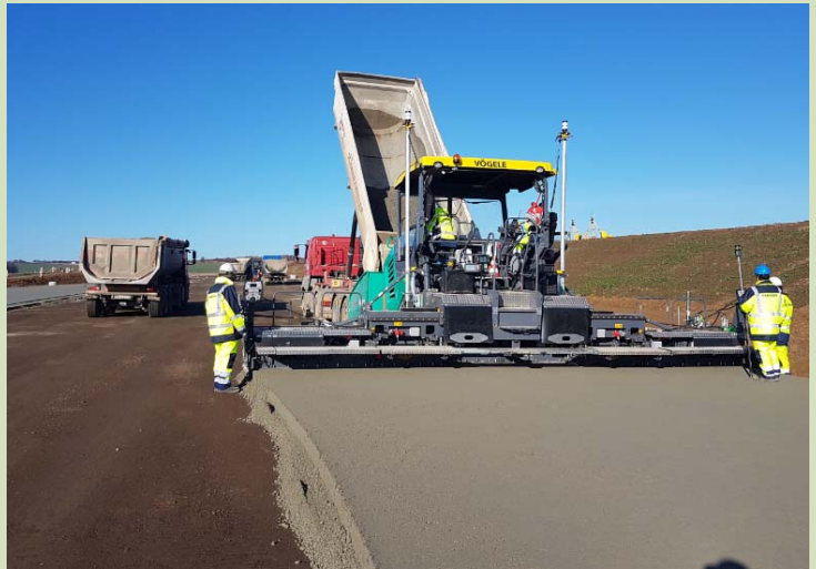
D1 - Budimír - Bidovce - pokládka betónovej stabilizácie (CBGM)
